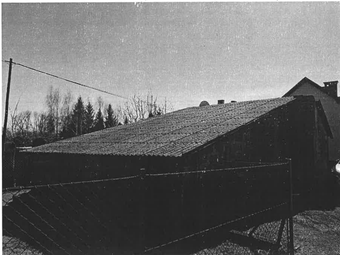
Rysunek 6 Dach budynku gospodarczego pokryty płytami azbestowymi falistymi (budynek przykładowy)
