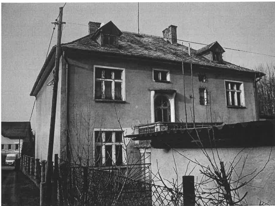
Rysunek 9 Dach pokryty płytami azbestowymi płaskimi (budynek przykładowy)
